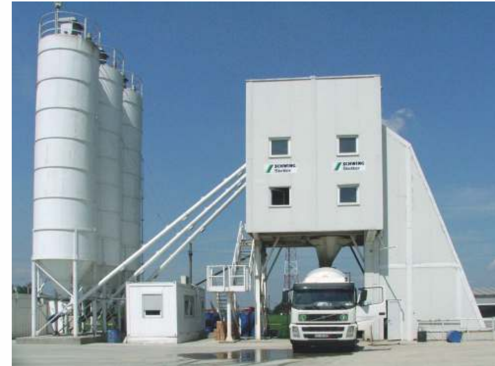
Planta HN con Mezcladora de Plato. Capacidad de 100 m 3 /h de concreto compactado.
