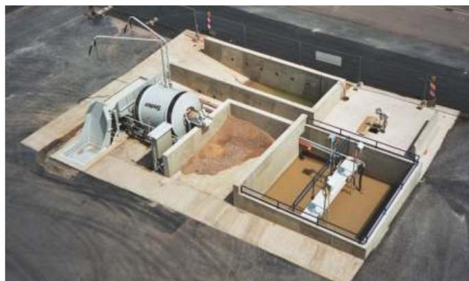
Modelo de uma RA 12: Adicionalmente aos tanques de agitação são instalados tanque de água limpa e tanque de decantação.
