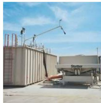
Instalação sobre o solo com container duplo para acúmulo de água residual. Recomendável para superfícies rochosas e instalações móveis.
