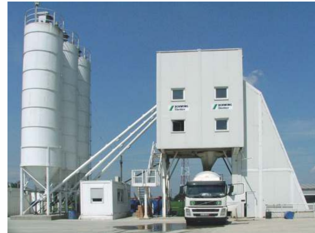
Central HN com misturador planetário. Capacidade de 100 m 3 /h de concreto compactado.
