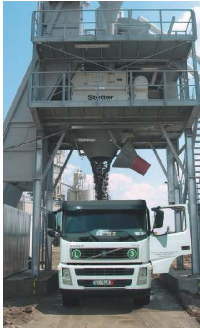
Descarregamento direto no caminhão caçamba.
